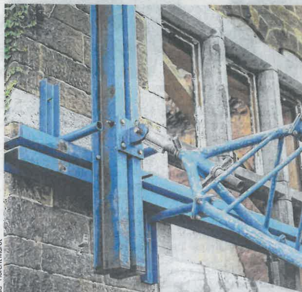
Oui, une façade peut être « épinglée »: c'est la technique utilisée au 75 de la rue Mazy.
