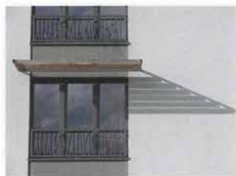
Détail d'un brise-soleil © Atelier de l'Arbre d'Or
